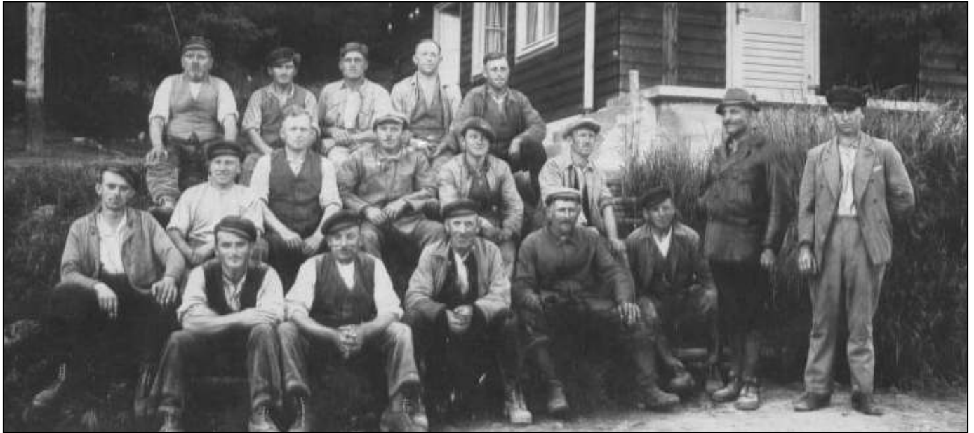
Bild von 1928. Röhrenwerk "am Schacht", heute Kläranlage. Hier fanden viele Brücker einen Arbeitsplatz.
